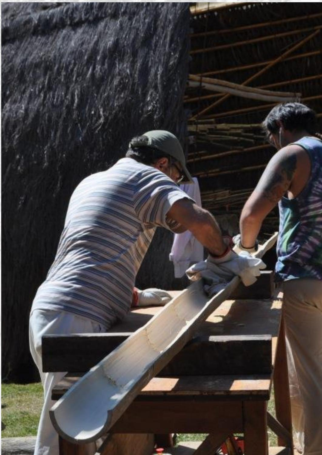
Foto 10: Corte das peças para fabricação das telhas
